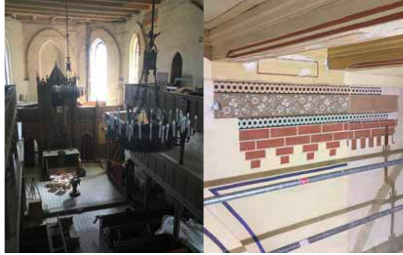
Stadtkirche Goldberg Vorzustand Musterfelder nach Befunden
